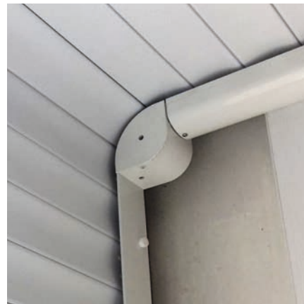
Finition des coulisses horizontales avec un cache arrondi en alu laqué
