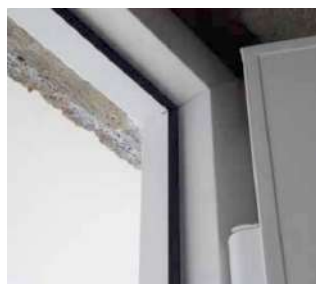
Précadre avec joint de série, assure une bonne finition surtout en rénovation
