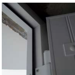
Pré-cadre avec joint de série, assure une bonne finition surtout en rénovation
