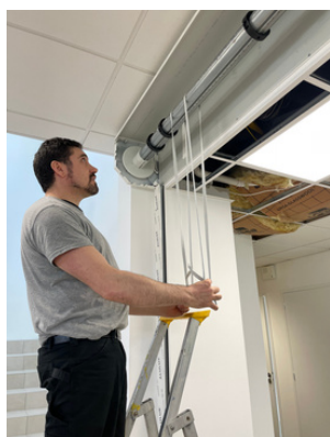
Mise en place des sangles sur chaque extrémités
