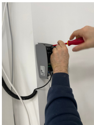
Fixation du boîtier
