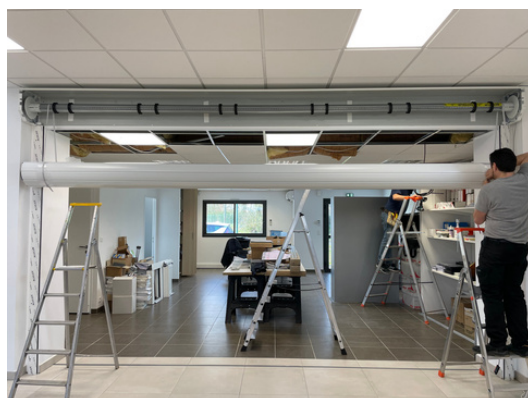
Insérer le tablier dans les sangles
