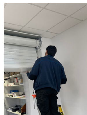
Penser à soulager le tablier lors de la remontée
