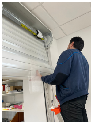
Faire remonter le tablier à l'aide du bouton "+" ou "montée" selon le type de boîtier.
