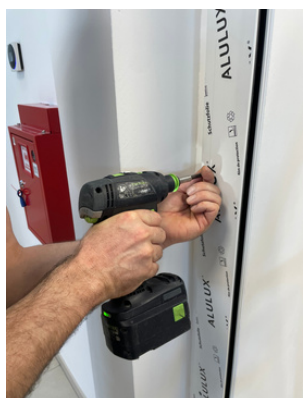
Fixation des coulisses
