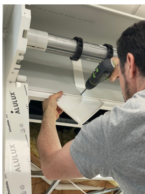
Fixation du dos de coffre
