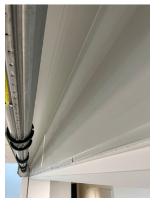
Mettre une vis tous les 20 cm en partie basse
