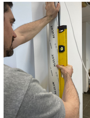
Vérification des niveaux et aplomb des coulisses et du coffre
