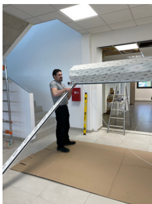
Mise en place du coffre et des coulisses assemblées
