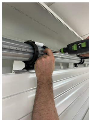
Vissez les bagues dans le tube avec la vis fournis impératif (13 mm maxi pour ne pas toucher le moteur)
