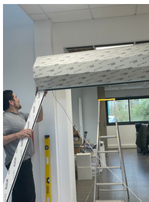
Pensez à soutenir le coffre de chaque côté pour ne pas forcer sur les coulisses et endommager les queues de joues
