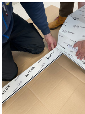
Vérifier la mise en place de la coulisse
