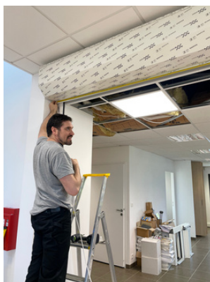
Vérification des diagonales
