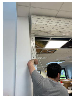
Plaquer les coulisses et le coffre contre le support
