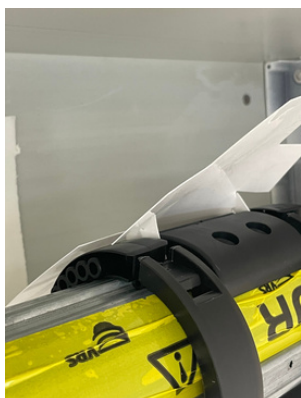
Mise en place des verrous Mettre les ergos dans le trou le plus haut des bagues
